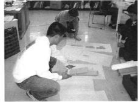
材料を購入後、図面を元に墨だしの作業
